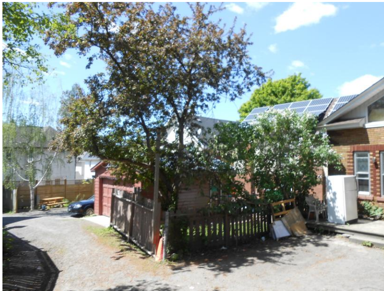
Rear of 80 Wurtemberg St.
